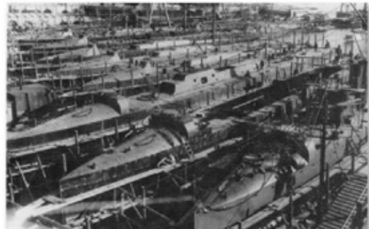
Studen torpédoborec typu PUSZAR, lodénici Stabilimento Tecnica Triestina. V popředí trup torpédoborce ULAN.
