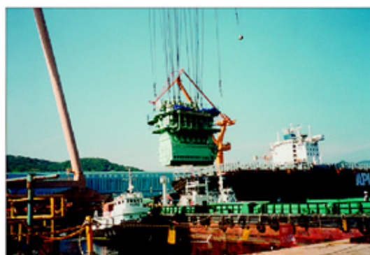
Nahoře: Lodi motor zavěšený na jeřábu.
