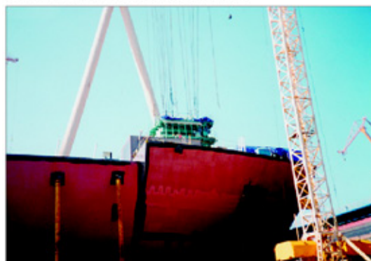
Dole: Spouštění hlavního motoru do prostoru budoucí strojovny.
